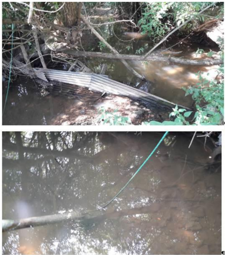
Figure 22 : Barrage pour le pompage, 2018
