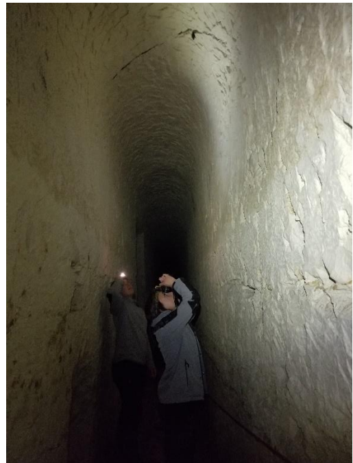
Figure 30 - Prospection du tunnel de Gouaix en 2022
