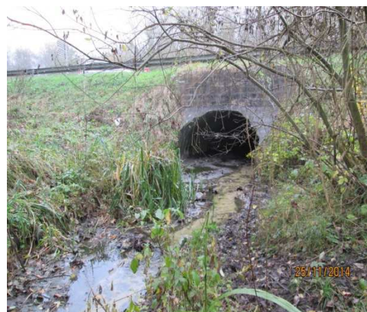
Figure 4 : Tunnel d'écoulement entre le Bois de Brou et le Bois de Vaires (Photos © AEV, 2014)
