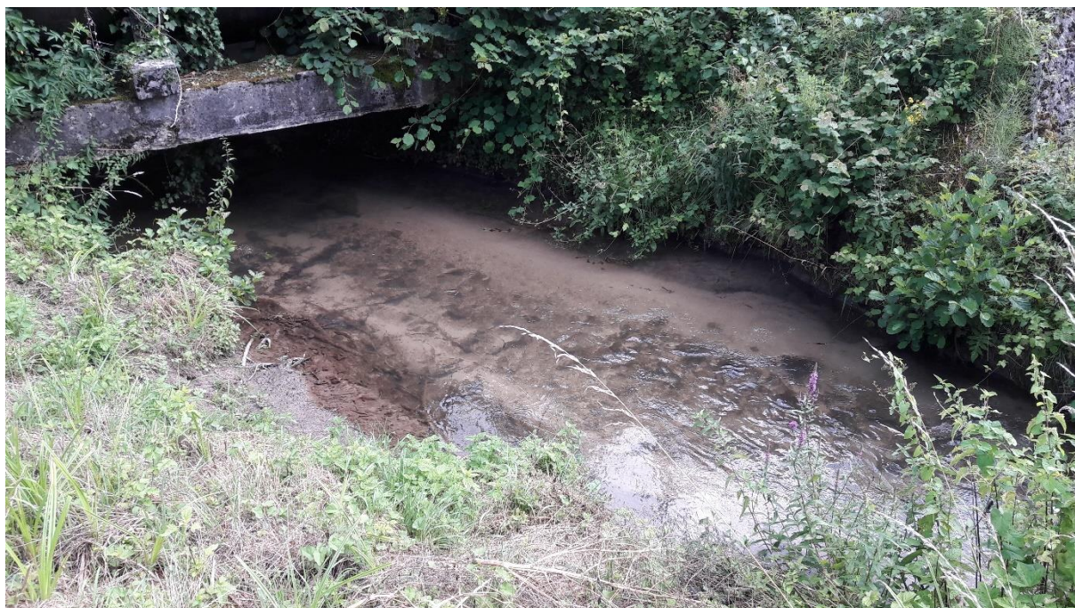
Parcelle 192 -95 Aqueduc – Végétation broyée
