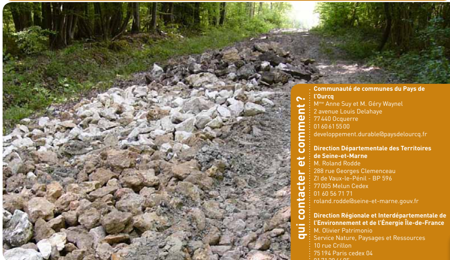
Remblaiement d'un chemin par dépôts de pierres © Biotope
